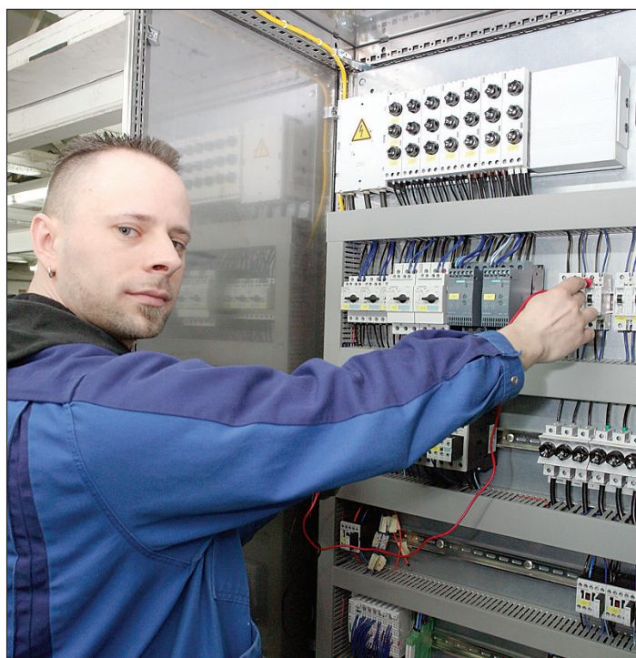
Elektroinstallateur Niels Möllenbauer prüft die Elektrik eines Schaltkastens.
